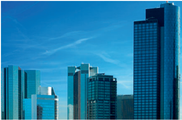
Bürogebäude / Office buildings
